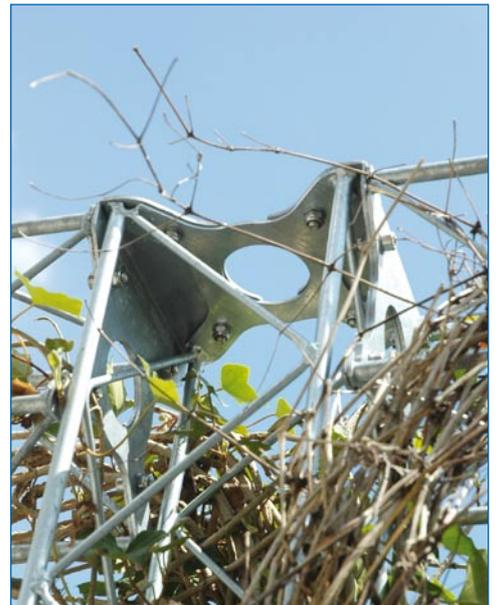
Das System wird mit Ranksäulen, -trägern, Verbindungs- und Fuss-elementen zusammengebaut. Verbindungsteile wie Eckverbinder, Stossverbinder usw. lassen viele Formen zu.
