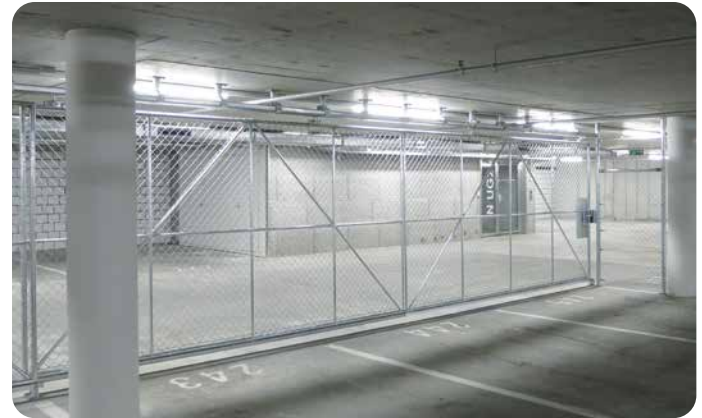
Schiebetür mit Deckenlaufschiene
