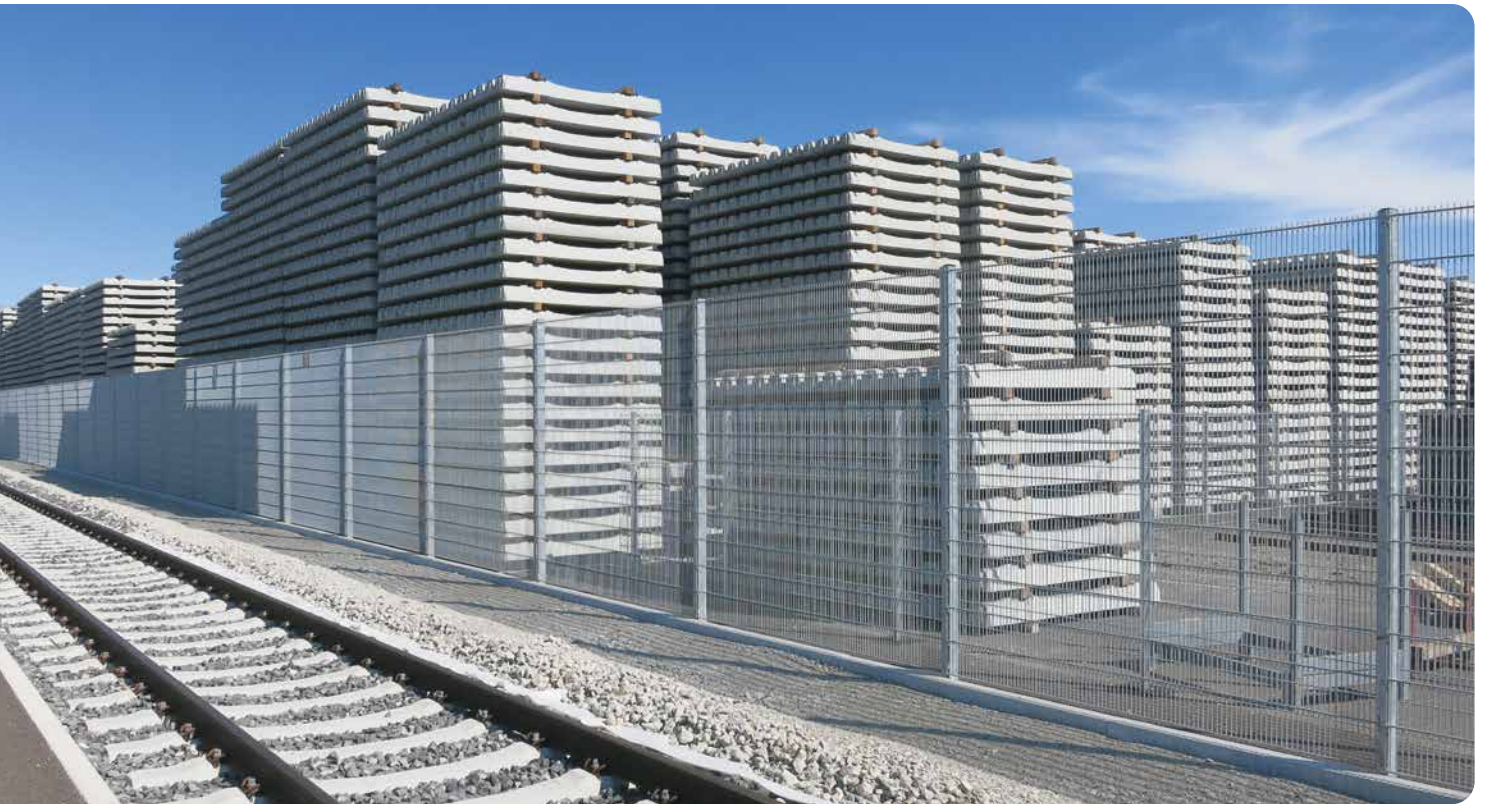
Stahlgitterzaun mit Masche 25 × 200 mm
